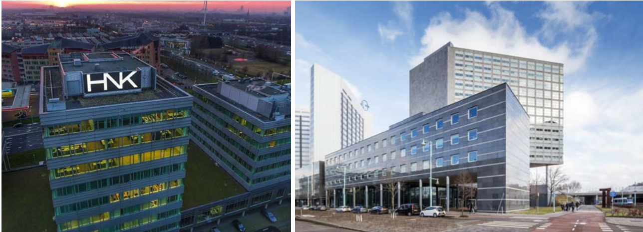
Figuur 7: Het HNK Kantoor van NSI in Den Haag (l) (bron: HNK.nl ) en het (r) Q-Park in Amsterdam (bron: NSI.nl )
